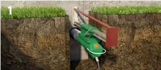
Алмазное сверление фундамента для прокладки канализационного трубопровода.
