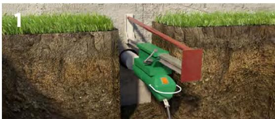
Алмазное сверление фундамента для прокладки канализационного трубопровода.
